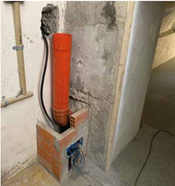
Predisposizione punto di estrazione
